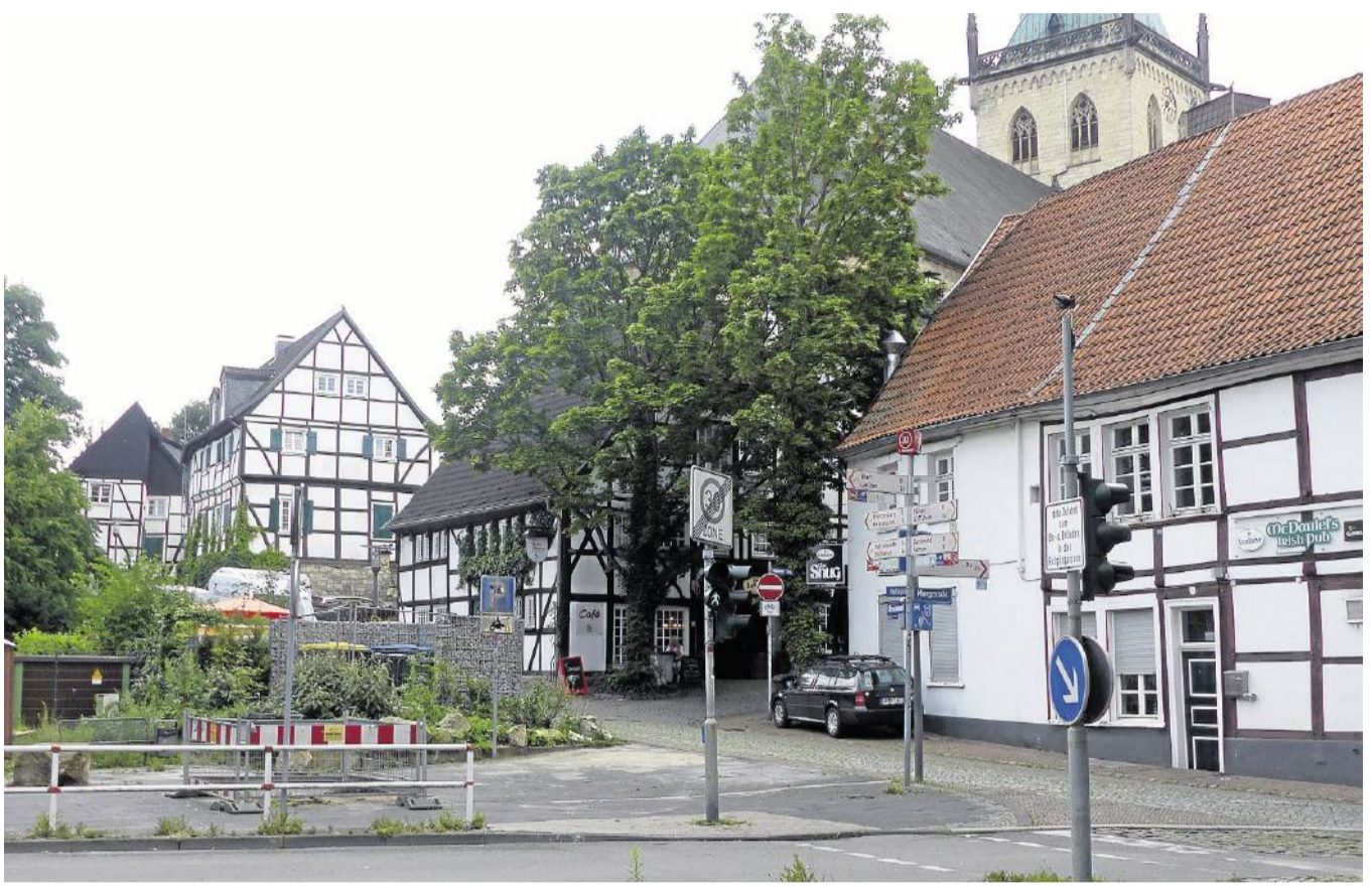
In zwei Wochen entsteht an der Kreuzung der Morgenstraße eine große Baugrube. Sie wird den Bereich der ehemaligen Stadtmauer tangieren, die entlang des heutigen Verkehrsringes verläuft. Fotos (2): Gemünd
