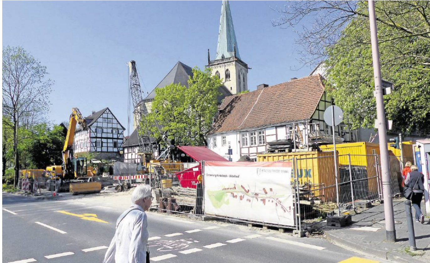
Fußgänger können den Ostring im Bereich der Morgenstraße derzeit nur an einer Baustellen-Ampel überqueren. Die Baugrube musste genau im Einfahrtsbereich zur Innenstadt angelegt werden. FOTO: GEMÜND
