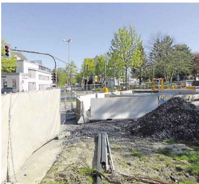
Am Montag wird ein Kran den Spezialbohrer aus der Baugrube an der Wasserstraße bergen. FOTO: GEMÜND
