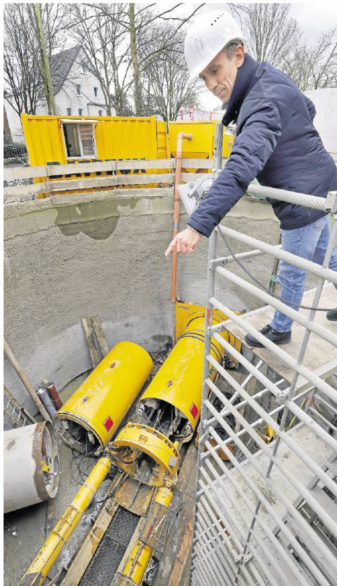
Projektleiter Thomas Matter zeigt auf den Spezialbohrer, der am Donnerstag in die Baugrube am Morgentor eingesetzt wurde.
