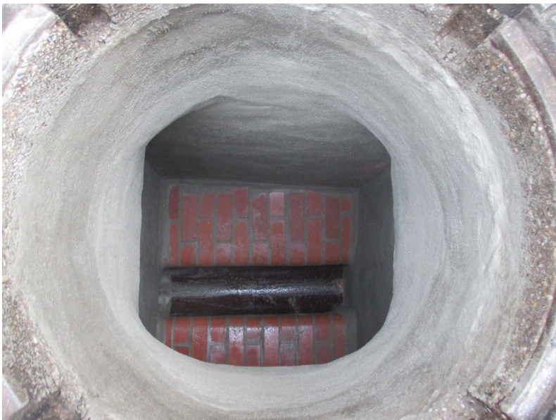
Schacht nach der Sanierung.
