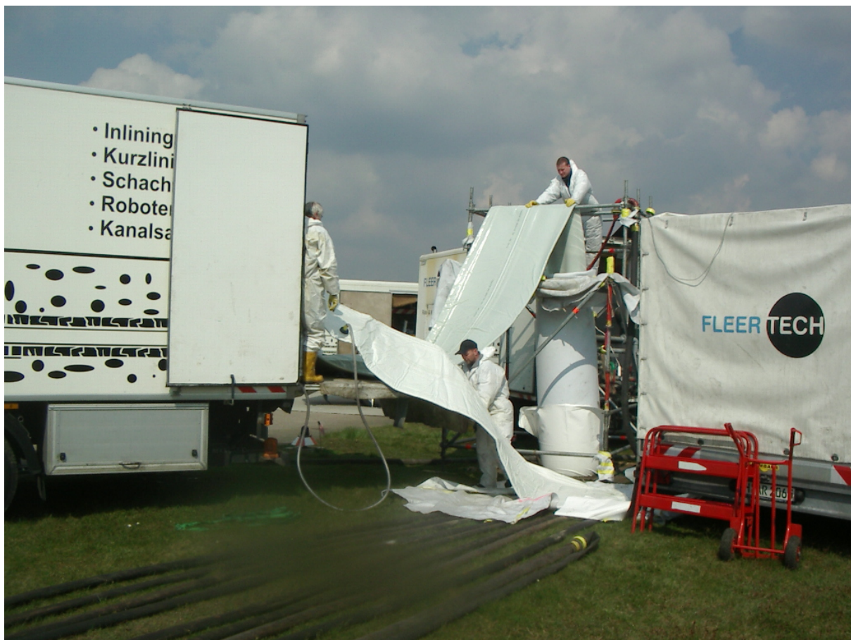
Linereinbau mit Tränkungsanlage und Gerüst.
