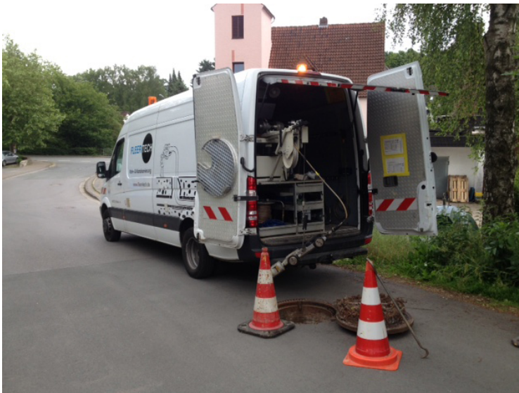
Die Kanäle werden mit einer Kamera untersucht.
