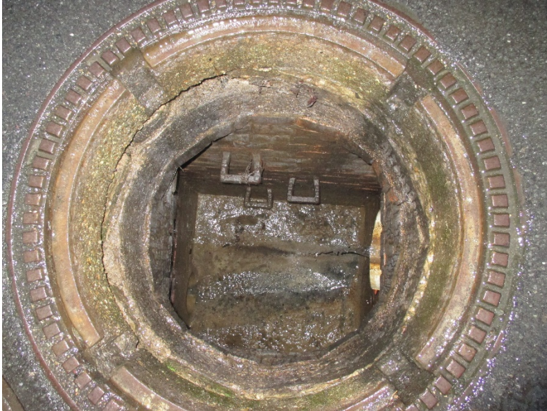
Schacht vor der Sanierung.
