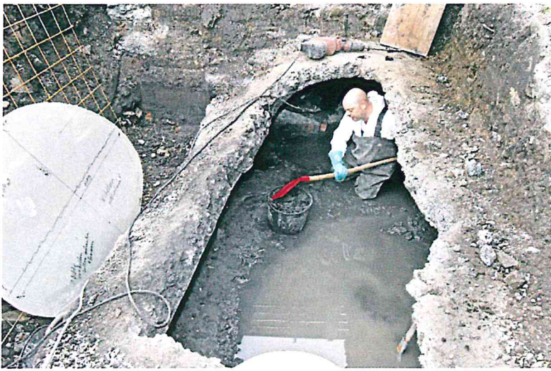
Ein Blick in den heutigen Kortelbach, aufgenommen bei einer „Kanalsanierung“ im Jahr 2012. Etwa ab 1855 wurde der Bach verrohrt und überbaut, 10.000 Unnaer nutzen ihn heute als Abwasserkanal. Diese Funktion bleibt auch zukünftig erhalten: Die Stadtbetriebe leiten mit dem geplanten Neubau nicht etwa das Abwasser um, sondern das Frischwasser des Kortelbachs. Foto: Archiv
