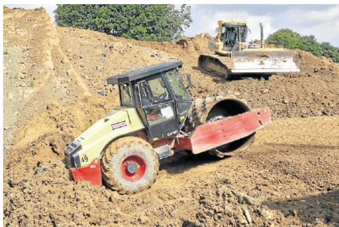
Mit Raupen und verschiedenen Walzen verteilen und lockern Arbeiter die Bodenmassen, die bereits angehäuft sind.
