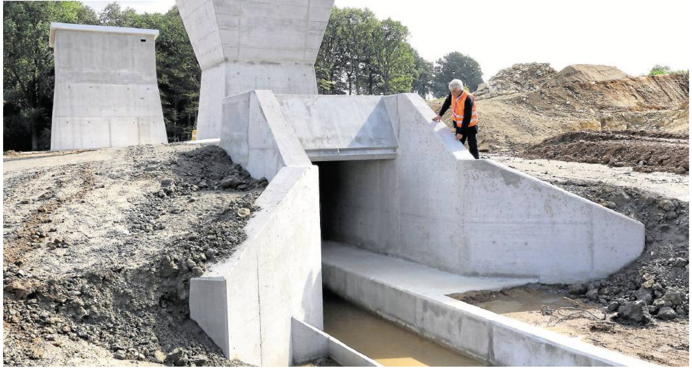
Auf der Baustelle im Bimbergtal wirkt ein Erwachsener winzig: Siegmund Kansteiner von den Stadtbetrieben begutachtet das Betonbauwerk, durch das bereits der Lünerner Bach leise plätschert. Sollte er einmal strömen, wird die Anlage ihn drosseln. In einigen Wochen wird die auffällige Installation fast vollständig von Erde überhäuft sein.
