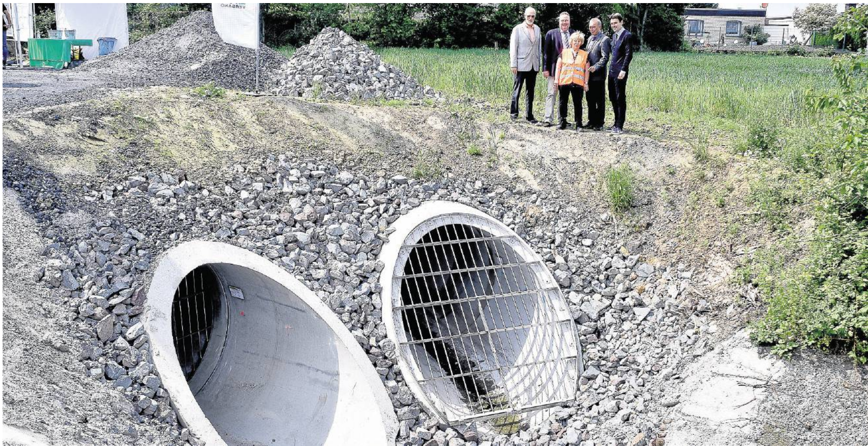
Aus dem linken Rohr tritt bei Starkregen vorgeklärtes Wasser aus dem Mischwasserkanal aus. Das rechte Rohr ist der Ausgang der Kortelbach-Verrohrung. Unsichtbar ist der nun fertiggestellte Mischwasserkanal. Die Größe der verantwortlichen Personen zeigt die Dimensionen.
