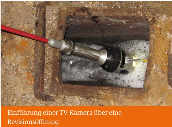
Einführung einer TV-Kamera über eine Revisionsöffnung
