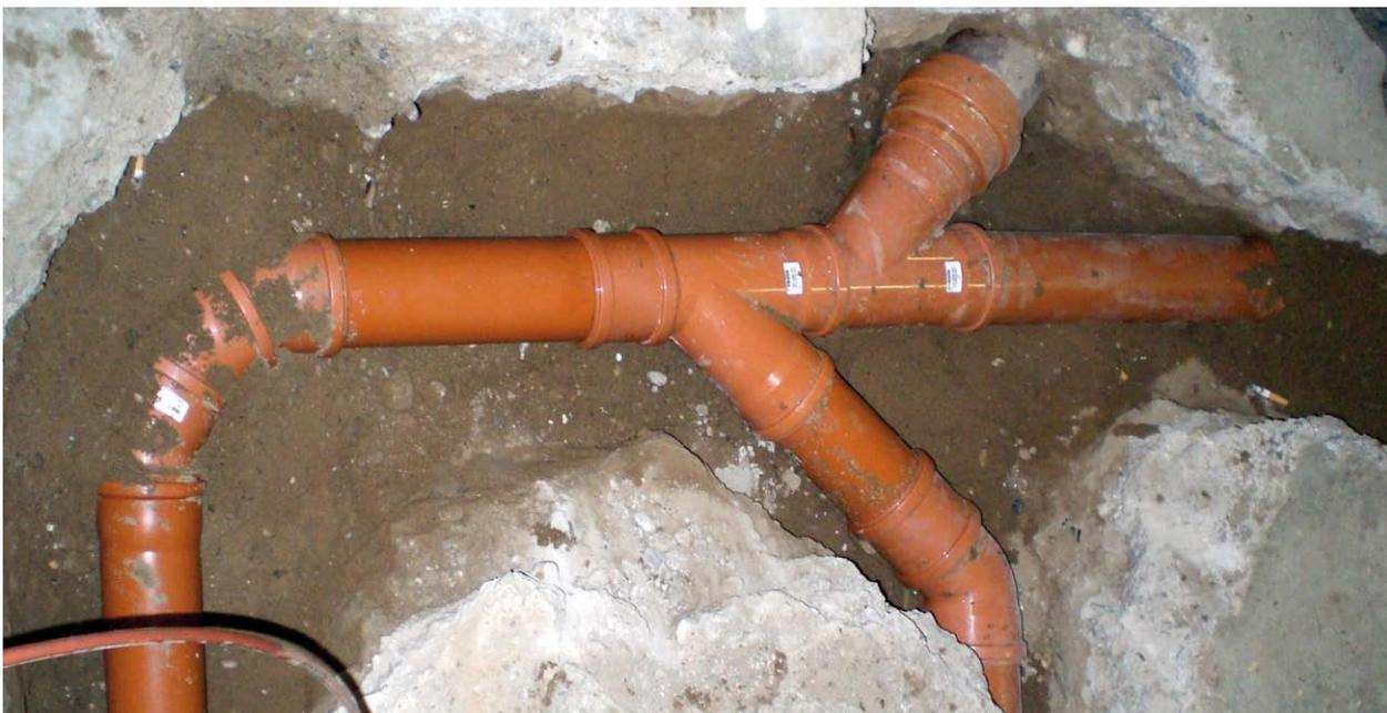
Aufwändige Erneuerung von Abwasserleitungen unter der Bodenplatte
