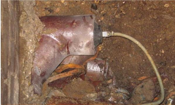
Absperrblase zur Dichtheitsprüfung
