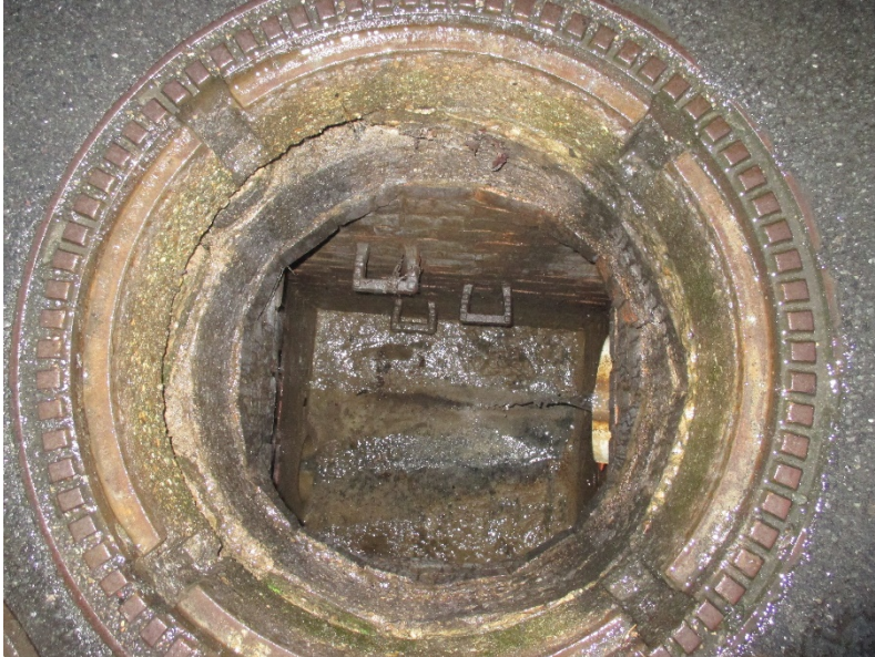
Schacht vor der Sanierung.
