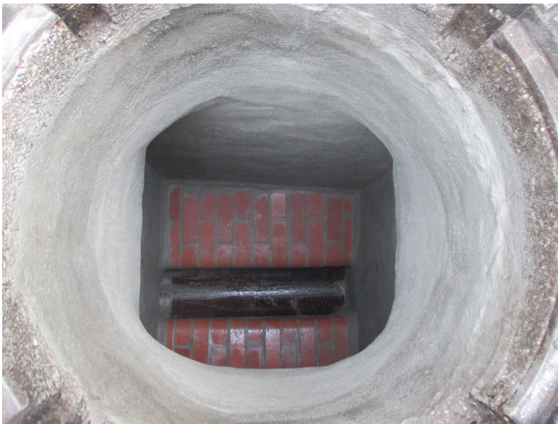
Schacht nach der Sanierung.
