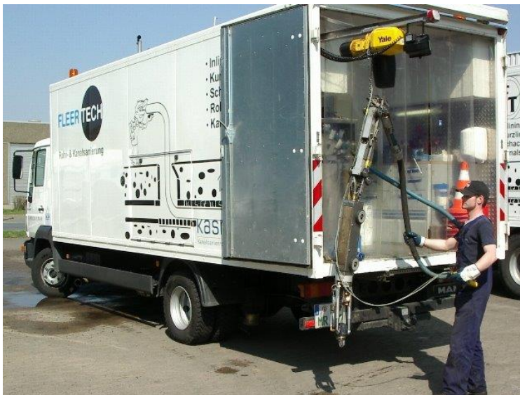
Die Kanäle werden mit einer Kamera untersucht.
