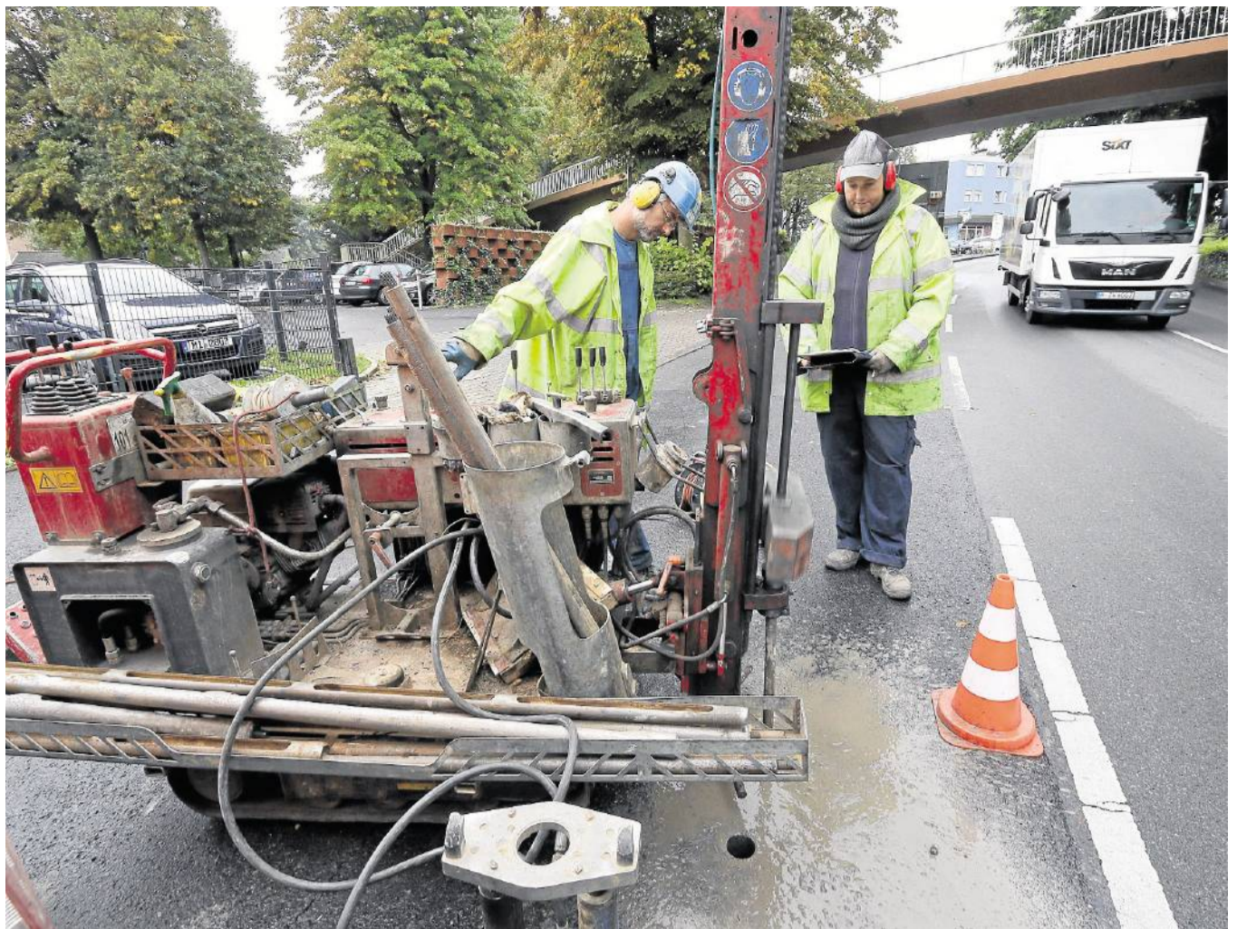
Bereits im Planungsstadium wurden entlang des künftigen Bachbettes des Kortelbachs Probebohrungen, wie hier am Südring, vorgenommen, um auch nach möglichen Bombenblindgängern zu suchen. Fotos: Archiv
