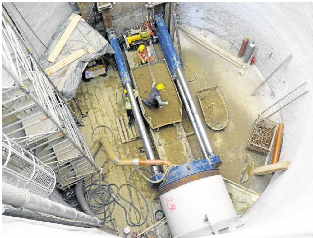
In bis zu zehn Metern Tiefe verläuft das neue Bachbett. Damit bei einem möglichen Unfall die Rettung reibungslos klappt, wurde die Feuerwehr in die Vorplanungen mit einbezogen.
