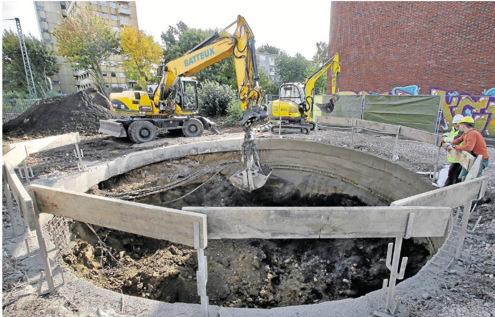
Dieser Schacht wird neun Meter in die Tiefe gehen, wenn der Aushub beendet ist. Erst dann kann die Maschine für den Rohrvortrieb hinabgelassen werden. Foto: Hennes
