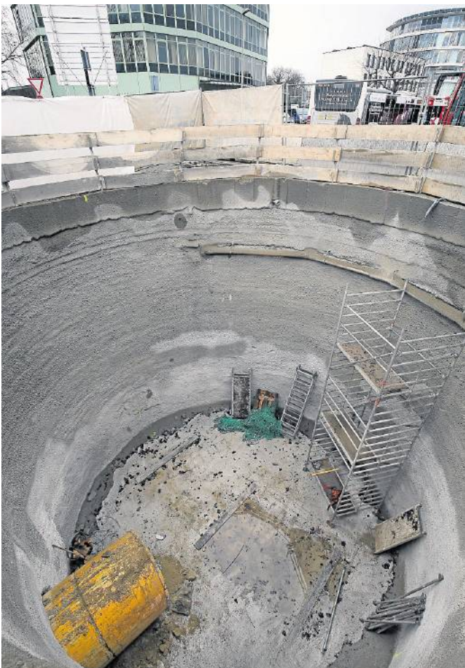
In diesem Schacht ist der Kortelbach-Bohrer angekommen. Von hier aus geht es demnächst weiter durch den Untergrund bis zum Hellweg, links vorbei am grünen AOK-Gebäude.
