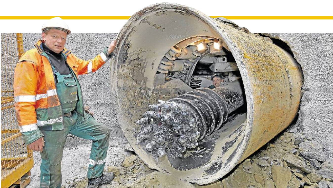
Polier Alfons Flasche (l.) kann den Maschinisten Bastian Lenz wieder sehen. Lenz steuert den unterirdischen Spezialbohrer durch den Untergrund und hat seine erste 90-Meter-Strecke fertig gestellt.
