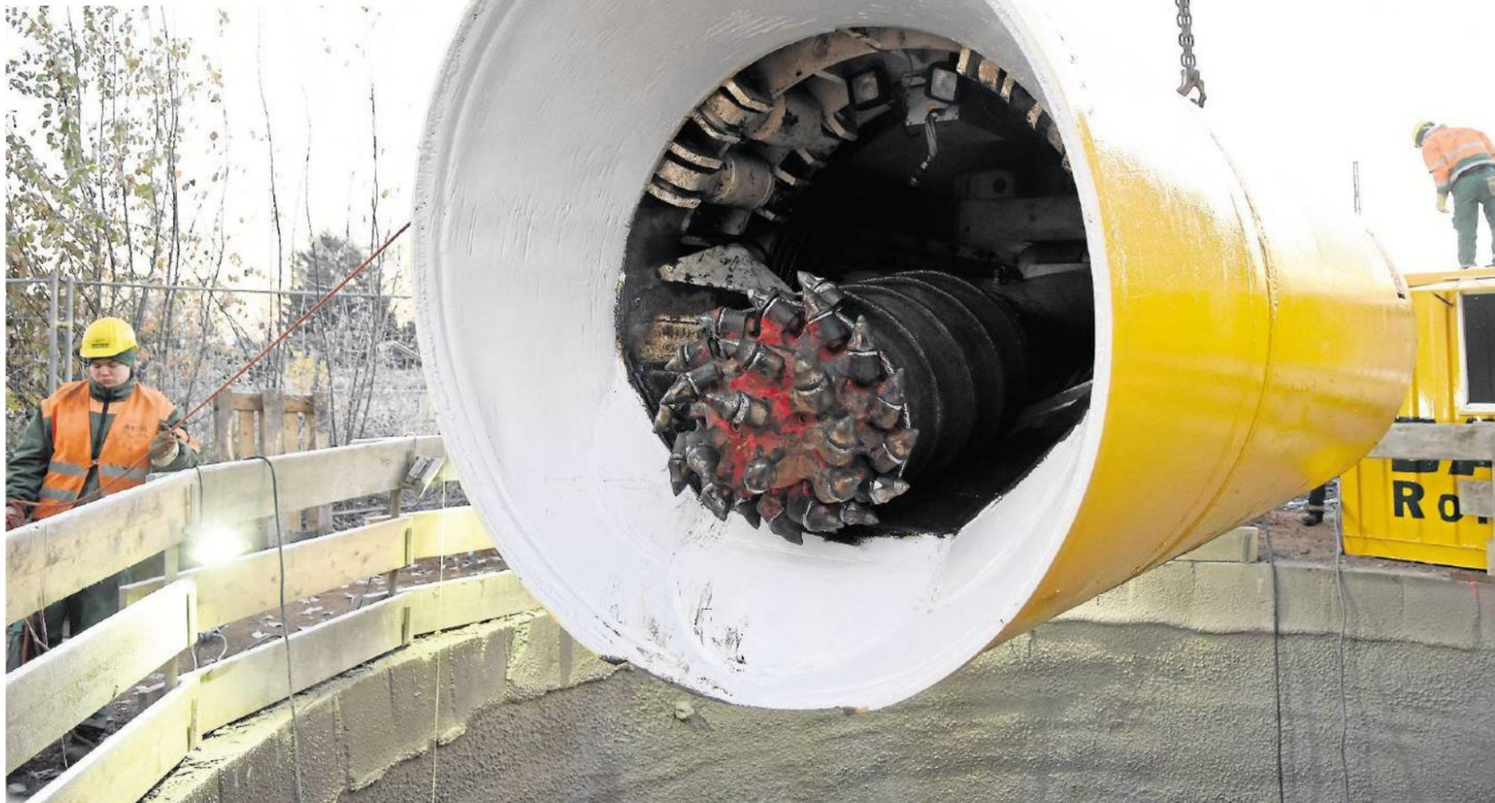
Vorsichtig wird das 16 Tonnen schwere Stahlbetonrohr mit dem Bohrer an der Spitze in die Tiefe gelassen. Pendeln darf das Rohr nicht, sonst schlägt es an der
