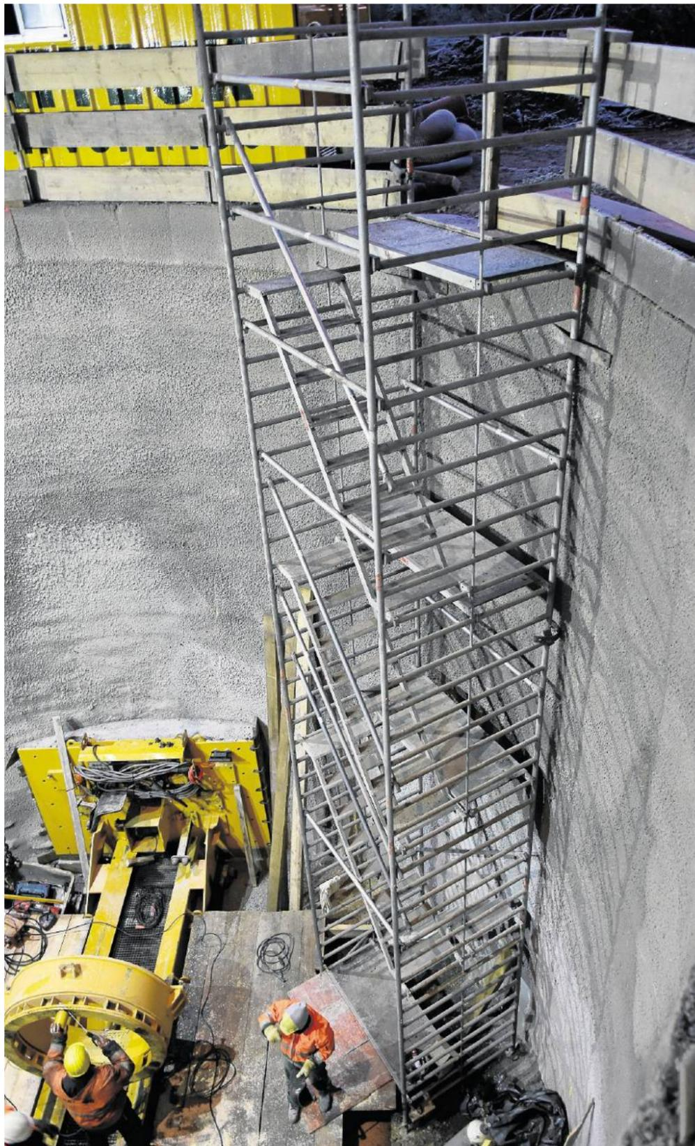
Neun Meter tief ist die Schachtgrube neben dem Busbahnhof. Auf dem Pressschlitten links wird der Bohrer hydraulisch vorangetrieben.
