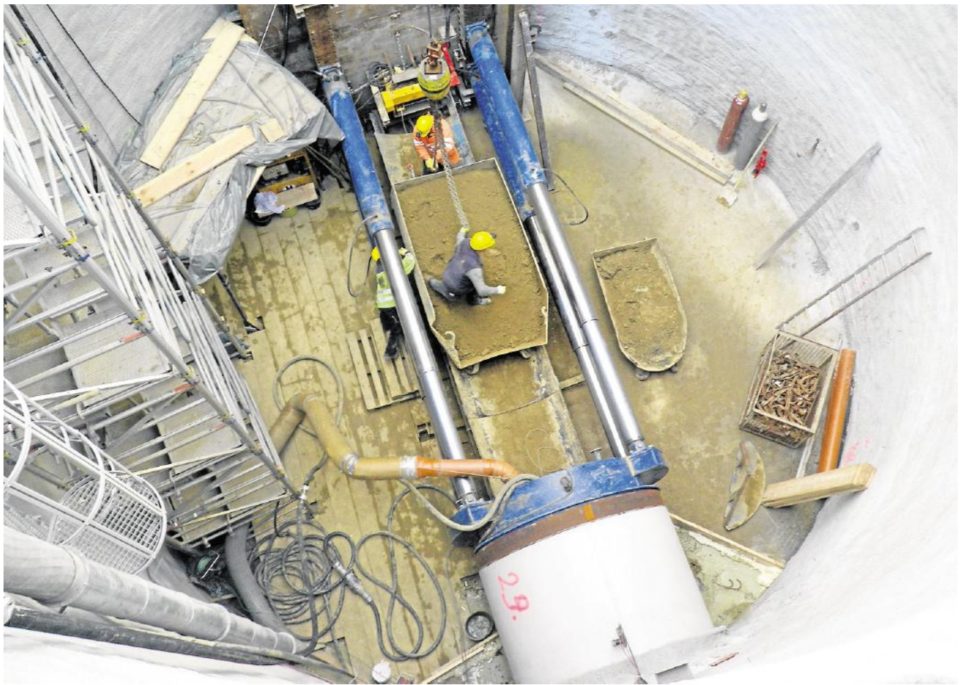
Eine hydraulische Presse schiebt nach und nach ein neues Rohr durch den Untergrund. So ähnlich werden auch ab 2016 in Unna die Baugruben aussehen, von denen aus das neue Bett für den Kortelbach unter der Stadt hindurchgebaut wird. Der Aushub erfolgt dabei nicht mit einer ferngesteuerten Maschine, sondern bemannt. Foto: S & P Consult GmbH
