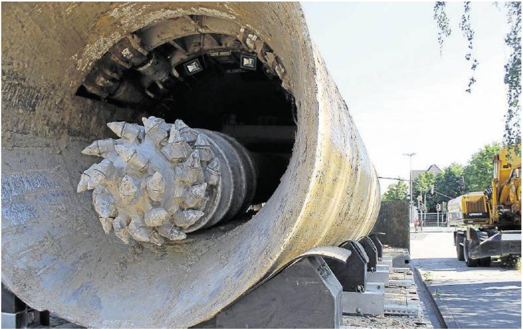
**Nach der Bergung aus der Schachtgrube an der Ecke Südring/Wasserstraße geht das Bohrgerät in die Überholung. In zweieinhalb Wochen beginnt der letzte Vortrieb.**
